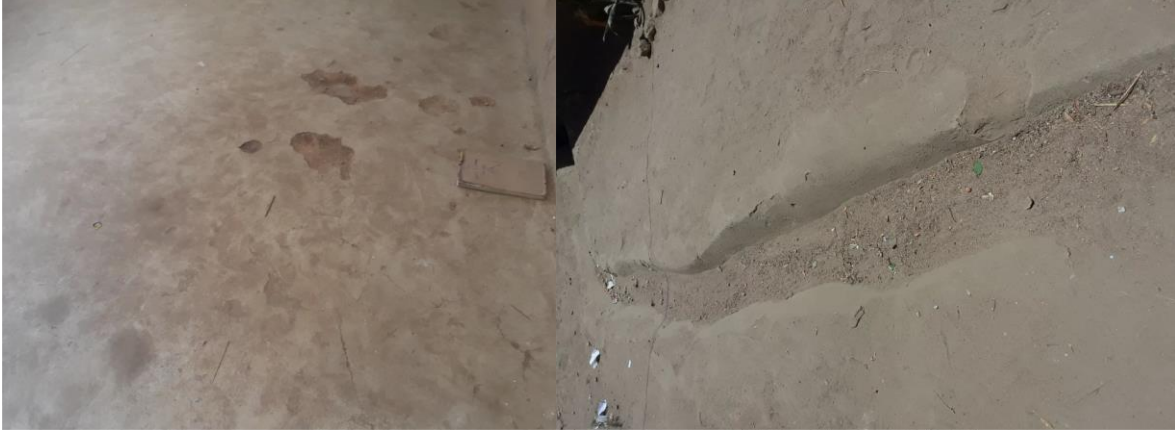
Picha 1: Picha hapo juu zinaonesha sakafu na mtaro wa maji machafu iliyojengwa chini ya viwango na zimeanza kubomoka.
