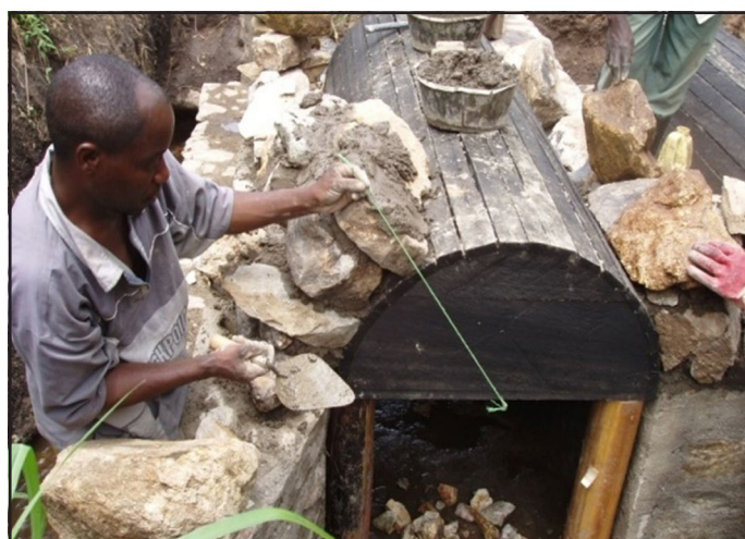
kielelezo 53: Sehemu sahihi ya mawe sambamba na nusu kipenyo cha upinde. Mawe ya upinde yanawekwa katika sehemu ya nusu kipenyo, kwa kipeo cha scaffold. Mraba wa uashi unaashiria sehemu sahihi kwa kila jiwe, ikiwa kasha linalingana. Kwa makalavati, kamba inawekwa katikati ya duara na itatumika kuonesha muelekeo sahihi.
