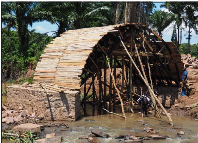
kielelezo 38: kila truss ya fomu ya mbao inakuwa na marobo duara mawili yaliyotengenezwa na kuunganishwa katika eneo
