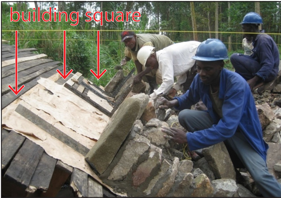
kielelezo 54: Kushoto: Kujenga miraba kunaonesha sehemu sahihi ya mawe katika kila hatua ya ujenzi wa upinde. Kulia: Ni muhimu sana kujaza uwazi kati ya mawe. Mawe madogo yataongezwa kwenye zege kupunduzza gharama za saruji na kuongeza uimara.
