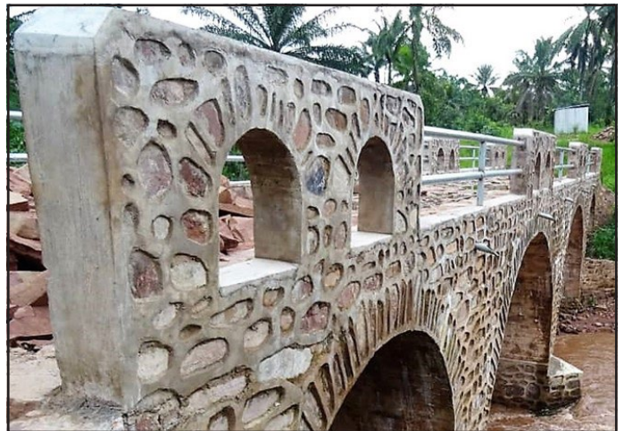
kielelezo 63: kuta za pembeni zilizoengwa kwa upinde kuokoa nyezo na kuogeza nguvu
