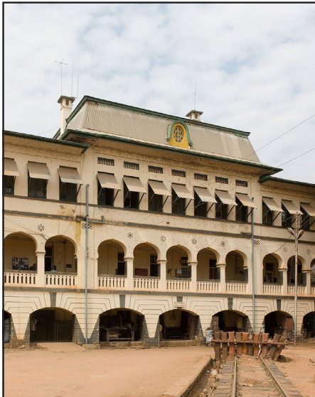
kielelezo 1: Matao ya uashi kama yanavyoonekana kwenye jengo la stesheni ya reli Kigoma, lilijengwa mwaka 1906
