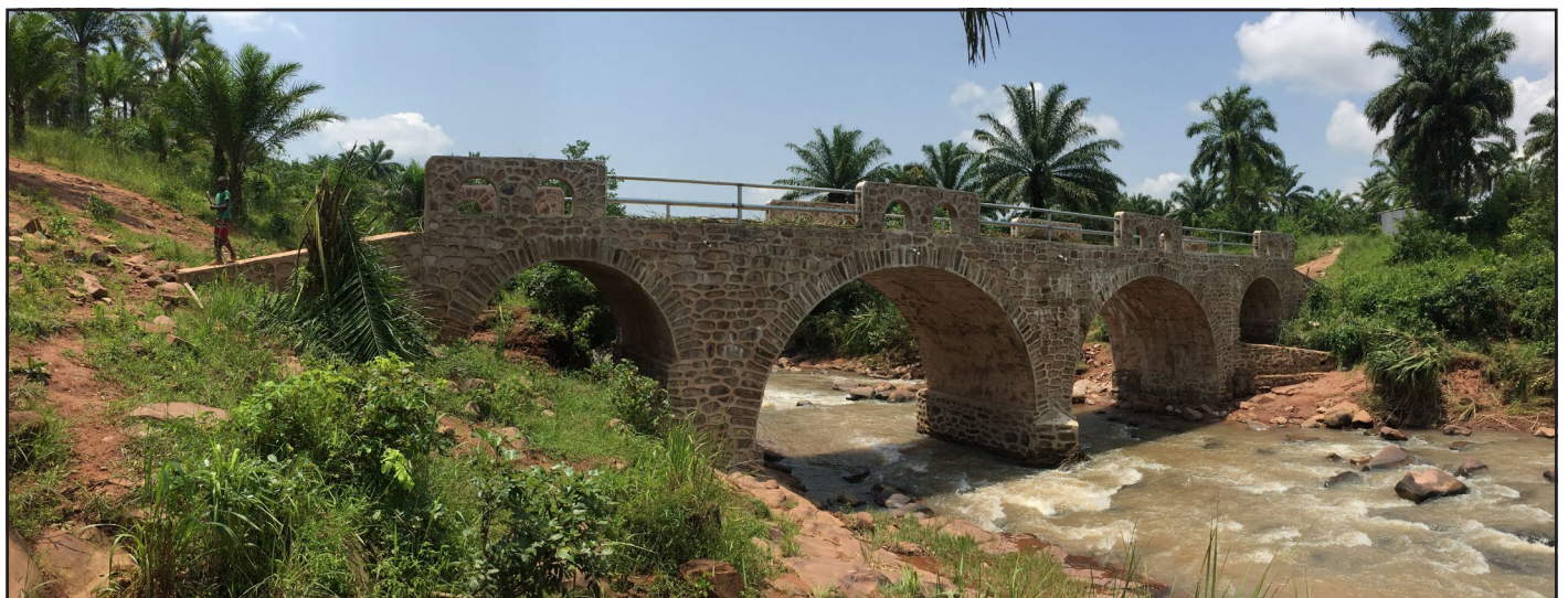
kielelezo 70: Madaraja mengi ya pinde za mawe yanaweza kutumika kufunika upana mkubwa. Upana wa daraja hili ni mita 32 na una pinde 4.
