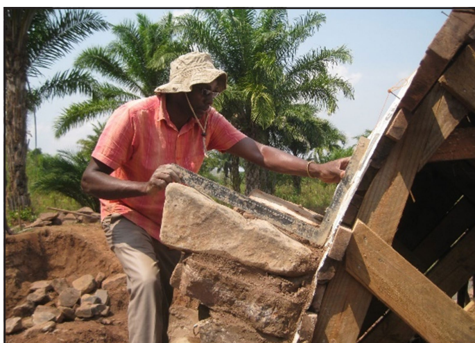
kielelezo 53: Sehemu sahihi ya mawe sambamba na nusu kipenyo cha upinde. Mawe ya upinde yanawekwa katika sehemu ya nusu kipenyo, kwa kipeo cha scaffold. Mraba wa uashi unaashiria sehemu sahihi kwa kila jiwe, ikiwa kasha linalingana. Kwa makalavati, kamba inawekwa katikati ya duara na itatumika kuonesha muelekeo sahihi.
