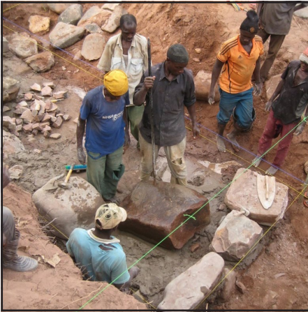
kielelezo 35: Mawe makubwa yanaongeza uwezo wa msingi kwa kiwango kikubwa na kupunguza gharama ya ujenzi. Mawe ya pembeni kwenye kona, mawe yenye pembe ya mraba huhitajika. Mawe yasiyo na pembe yanaweza kutumika katikati ya ukuba lakini sio kwenye pembe. Mawe madogo kamwe yasitumike.
