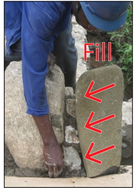
kielelezo 54: Kushoto: Kujenga miraba kunaonesha sehemu sahihi ya mawe katika kila hatua ya ujenzi wa upinde. Kulia: Ni muhimu sana kujaza uwazi kati ya mawe. Mawe madogo yataongezwa kwenye zege kupunduzza gharama za saruji na kuongeza uimara.
