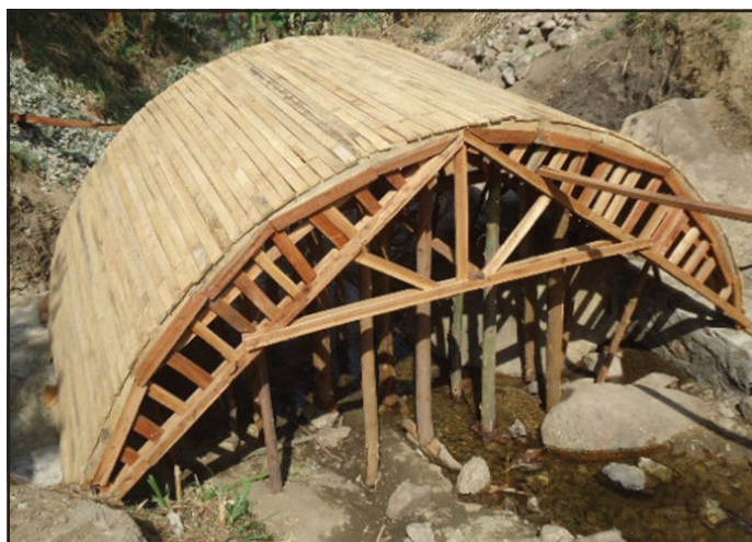
kielelezo 42 : Uwekaji sahihi wa upinde wa truss kuzingatia upana na upinde ni muhimu. Waashi wengi wanajitahidi kufuata misingi na mchakato utahitaji muongozo wa kitaalamu. A: Umbo sahihi la makasha ya mbao. B: Makasha ya mbao yasiyo sahihi yenye seti ya mistari minyoofu. Makasha haya yanatakiwa kubomolewa.
