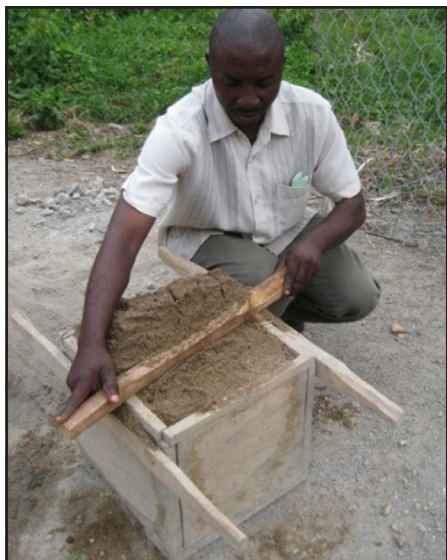
kielelezo 67: Ni sharti kutumia sanduku la batch lenye geji na rula ili kutengeneza kiwango kizuri cha zege. Mabeseni na matoroli yasitumike sababu ni vigumu kudhibiti kiasi halisi.
