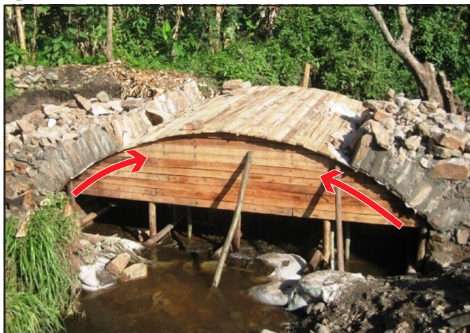
kielelezo 58: Kwa sababu za uimara, daraja linajengwa kwa usawa, hatua kwa hatua katika pande zote kwa muda mmoja (a). Ni hatari kujenga upande mmoja pekee kwanza (b). muundo hauwi salama hadi upinde unapofungwa katikakti.
