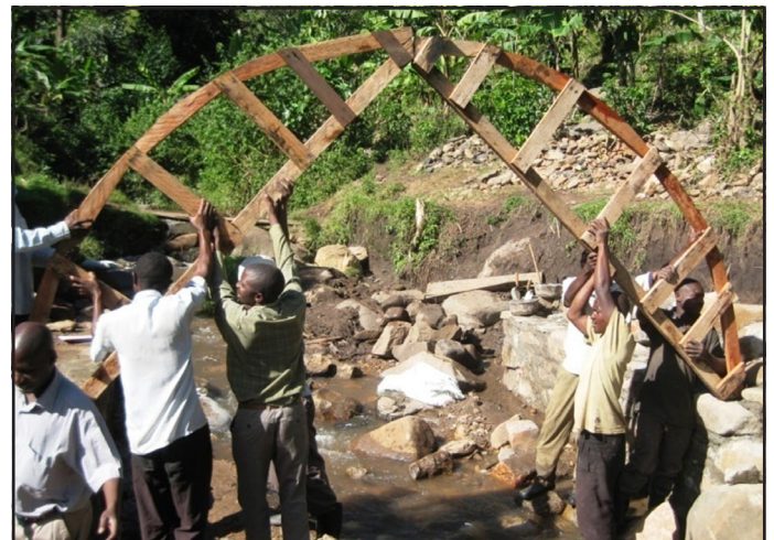
kielelezo 38: kila truss ya fomu ya mbao inakuwa na marobo duara mawili yaliyotengenezwa na kuunganishwa katika eneo
