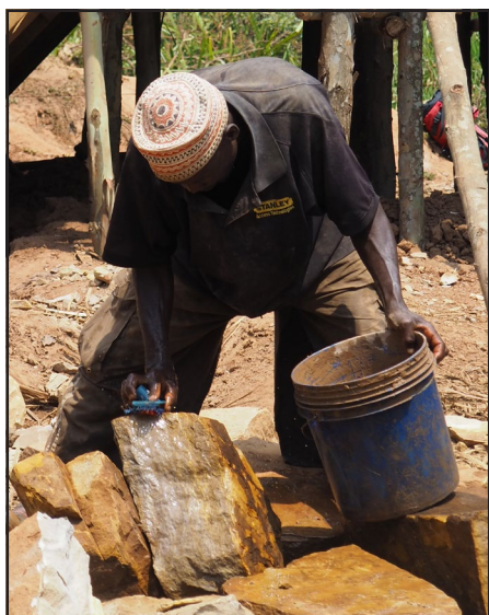
kielelezo 68: Kabla ya ujenzi, mawe yote yanahitaji kuoshwa ili kuhakikisha zege linashikana na uso wa mawe.
