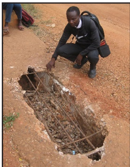
kielelezo 28: Kalvati ya zege iliyovunjika kutokana na ubora hafifu wa zege na kukosekana kwa kifusi. Kalvati za mviringo wa mawe hazipatwi na matatizo haya. Kalvati za mawe hubeba gari ya tani 40.
