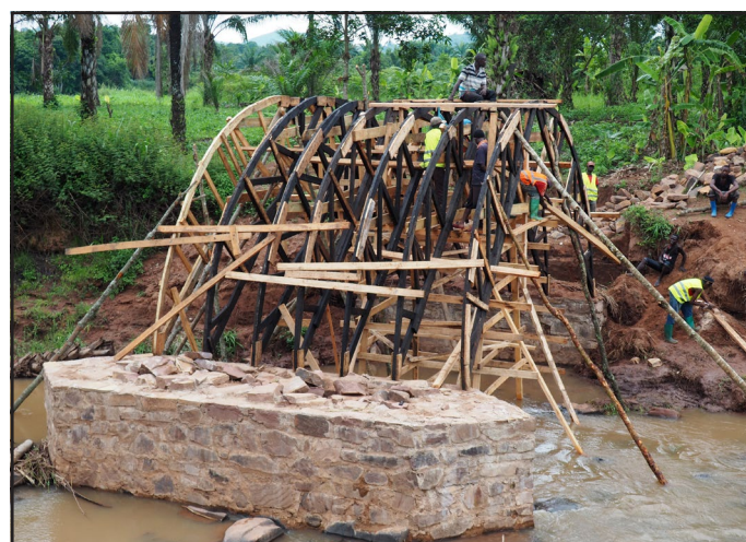
kielelezo 44 : Kenchi 7 zinahitajika kwa ajili ya kiwango cha upana wa mita 5. Kenchi zinatakiwa zishikiliwe na struts.
