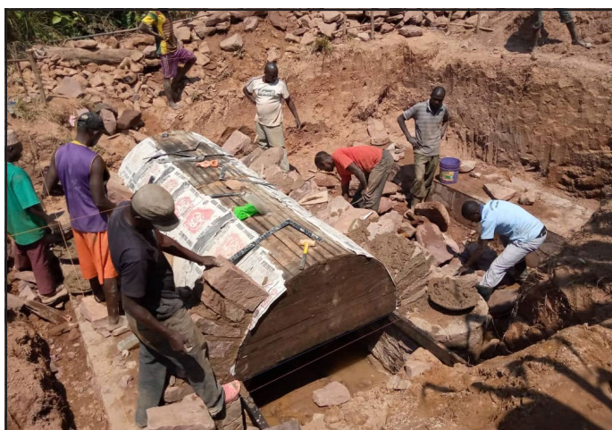
kielelezo 47: Maumbo ya makalavati ni kiwango (hapa ni kipenyo cha sm 80 na urefu wa mita 2). Yanaweza kutumika tena mara nyingi. Ukubwa wa karavati unaweza kurekebishwa kulingana na hali ya eneo (kingo, mtiririko wa maji) kwa kuongeza urefu wa pembeu au na maumbo mengi)
