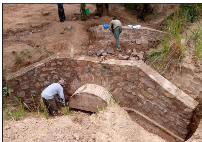
kielelezo 47: Maumbo ya makalavati ni kiwango (hapa ni kipenyo cha sm 80 na urefu wa mita 2). Yanaweza kutumika tena mara nyingi. Ukubwa wa karavati unaweza kurekebishwa kulingana na hali ya eneo (kingo, mtiririko wa maji) kwa kuongeza urefu wa pembeu au na maumbo mengi)
