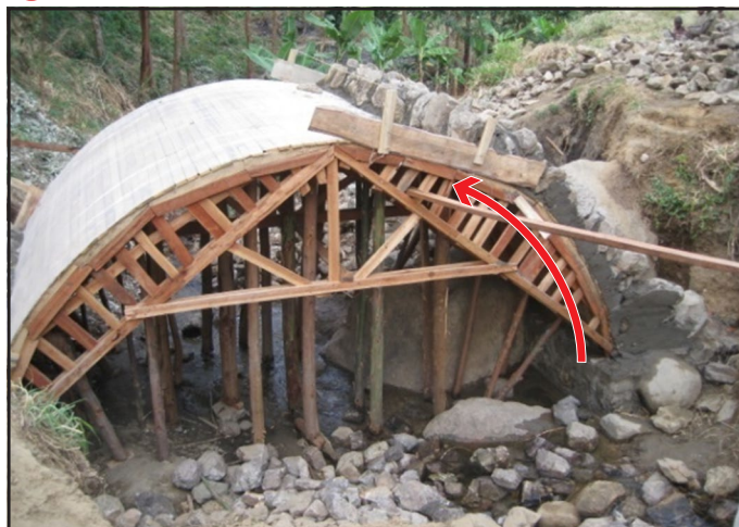
kielelezo 58: Kwa sababu za uimara, daraja linajengwa kwa usawa, hatua kwa hatua katika pande zote kwa muda mmoja (a). Ni hatari kujenga upande mmoja pekee kwanza (b). muundo hauwi salama hadi upinde unapofungwa katikakti.
