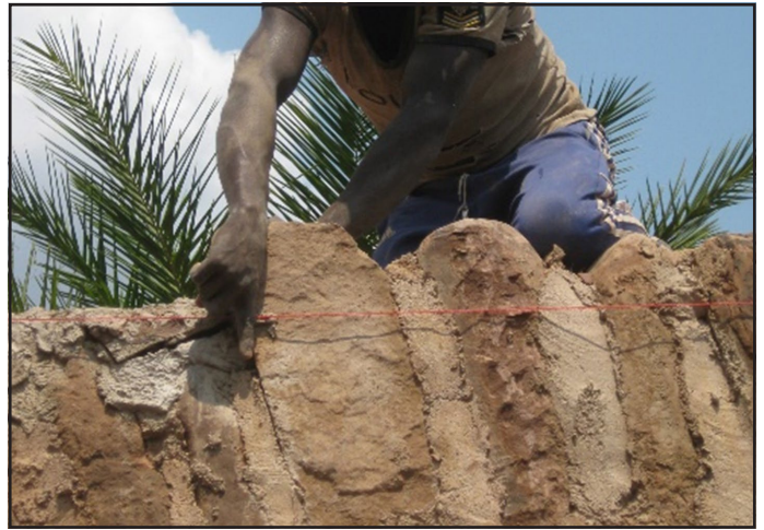
kielelezo 62: Kujengwa kwa mawe makavu na machafu kunasababisha nyufa kwakuwa mapovu au hewa hutokea kati ya jiwe na mota.
