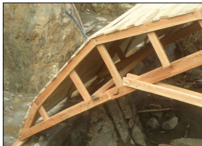
kielelezo 42 : Uwekaji sahihi wa upinde wa truss kuzingatia upana na upinde ni muhimu. Waashi wengi wanajitahidi kufuata misingi na mchakato utahitaji muongozo wa kitaalamu. A: Umbo sahihi la makasha ya mbao. B: Makasha ya mbao yasiyo sahihi yenye seti ya mistari minyoofu. Makasha haya yanatakiwa kubomolewa.
