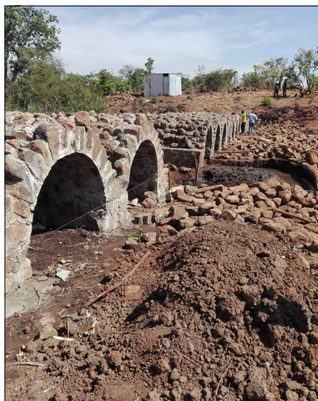
kielelezo 12: Ujenzi wa makalavati ya upinde unaojirudia rudia kwa kutumia mawe yanayopatikana katika eneo. husika
